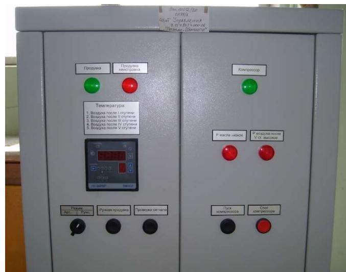
Рисунок 2.2 – Щит керування компресором (двері)
